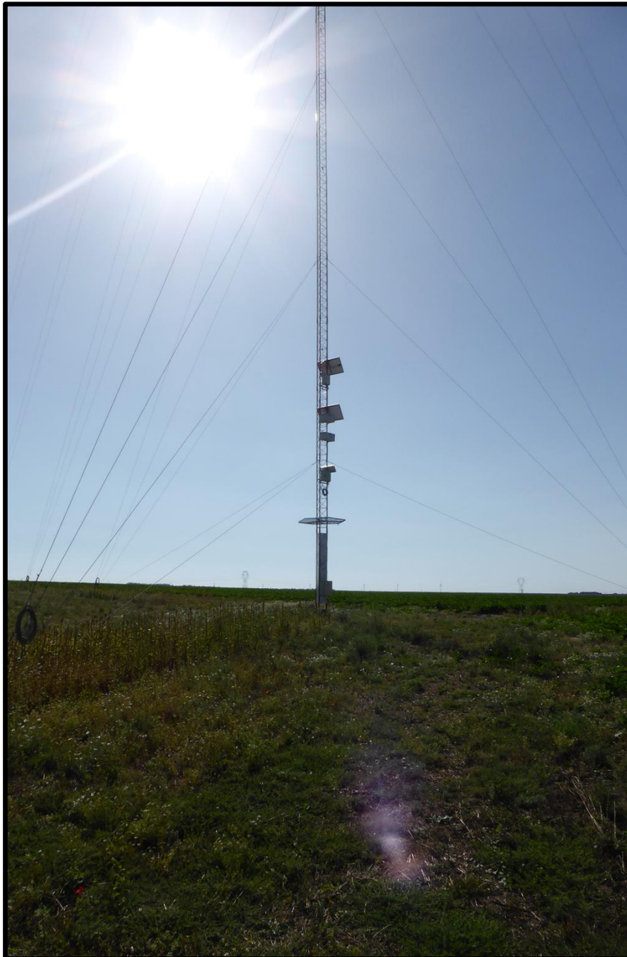
Photo 4 : mât de mesure de Gourgançon équipé du détecteur d'ultrasons
